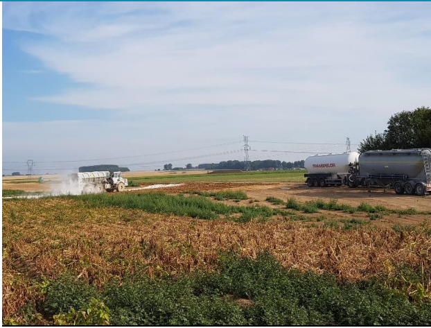
Traitement à la chaux conforme (faible envol), à proximité d'une zone sensible balisée.
