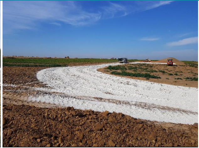
Traitement à la chaux conforme (faible envol), à proximité d'une zone sensible balisée.
