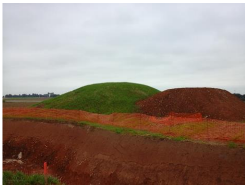
Figure 9 : Exemple de tri des terres sur une fouille de fondation d'éolienne
